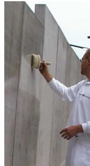
Nach der zweiten Applikation wird Protectosil ANTIGRAFFITI® mit einem Pinsel verstrichen.
